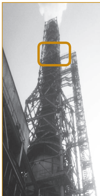
АИС установлен на отметке 64 метра
